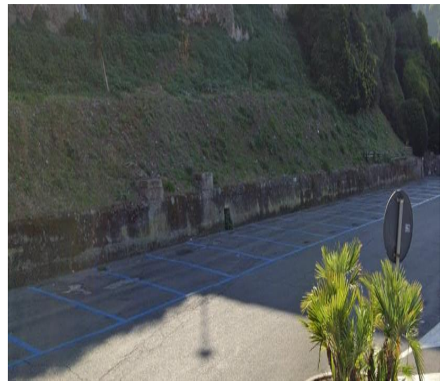
5 Parcheggio pubblico Via della Panoramica
