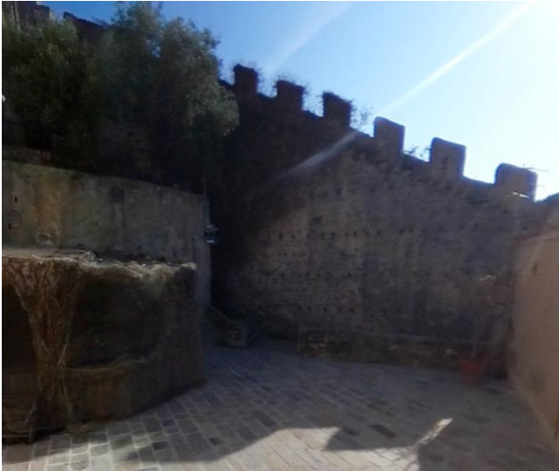
18 varco di ingresso per la chiesa di S. Erasmo
